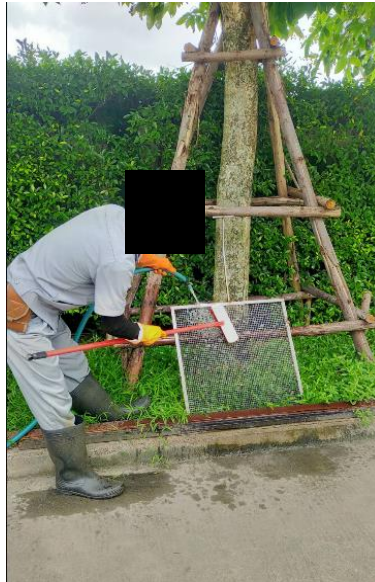
การทำความสะอาดตะแกรงดักมูลฝอย
