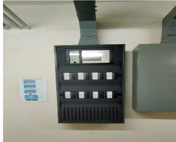
รูปที่ 1 ตู้ควบคุมระบบตรวจจับและแจ้งเหตุเพลิงไหม้
