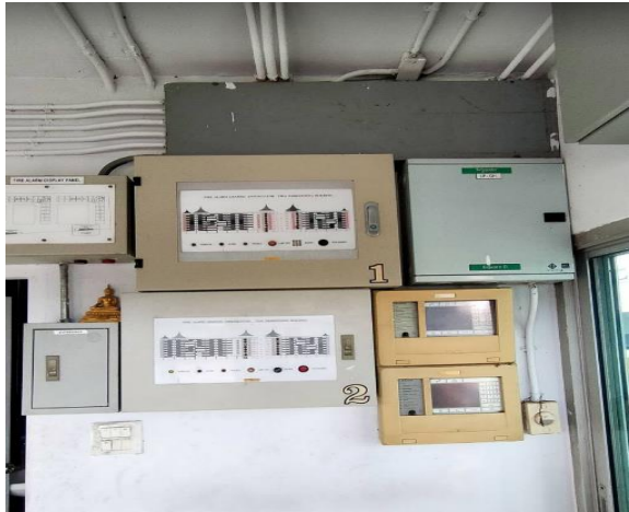
รูปที่ 1 ตู้ควบคุมระบบตรวจจับและแจ้งเหตุเพลิงไหม้
